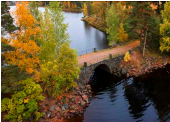
Old bridge, Tuula Lahtinen Kameraseura Mielikuva Finland
