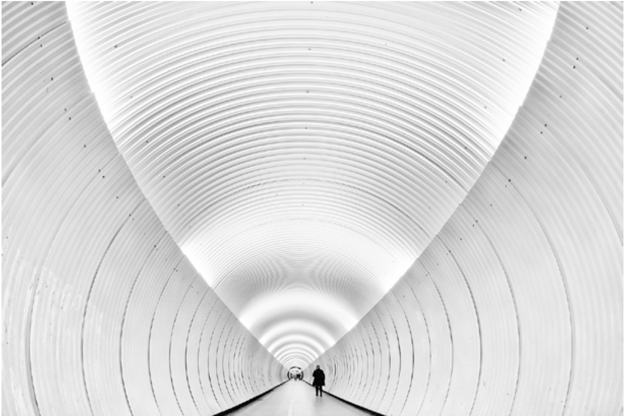
Brunkeberg tunnel, Mats Grimfoot EFIAP/s, NSMif/b, ERSF/b Image Group de Lux Sverige
